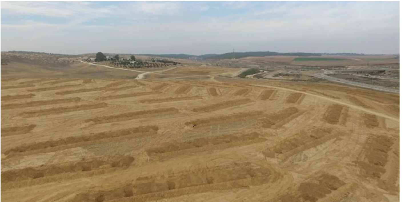
עבודות עפר להכשרת שטח נטיעה בשטח לס, צפון הנגב. הצומח הטבעי וקרום הקרקע - הוסרו לחלוטין. צילום: יוסף סגל
