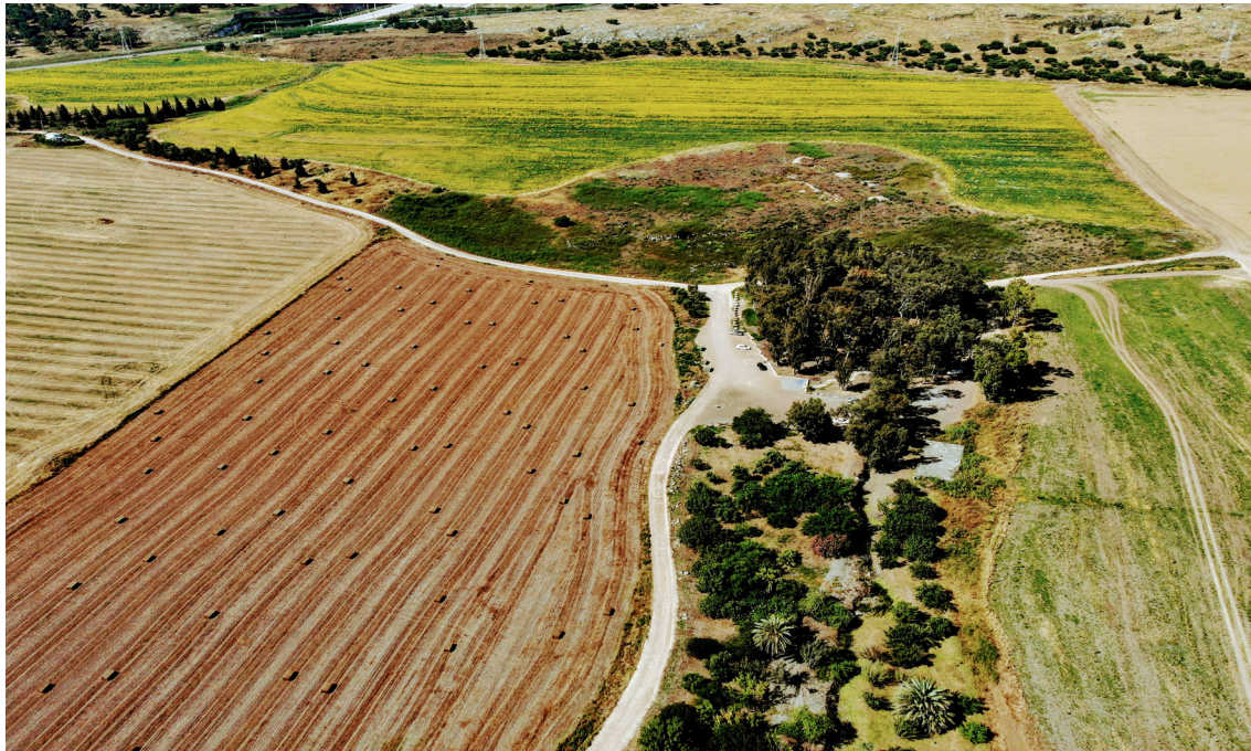
דוגמה למישרי שדה בשטח חקלאי סביב אפיק הנחל, היכולים לשמש כליבת מסדרון אקולוגי.
